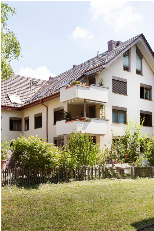
Fassade Südwest Neu
