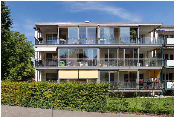
Fassade Südwest Neu
