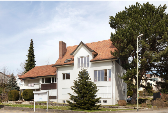
Südwest Fassade Bestand
