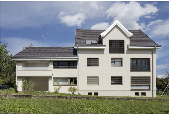
Südwest Fassade neu
