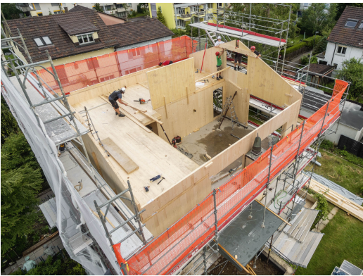
Umbauphase Dachaufstockung
