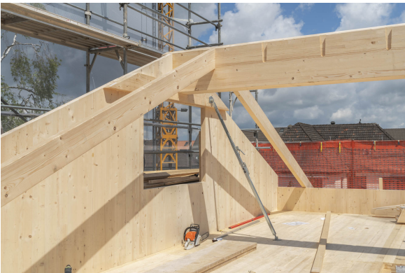
Umbauphase Dachaufstockung
