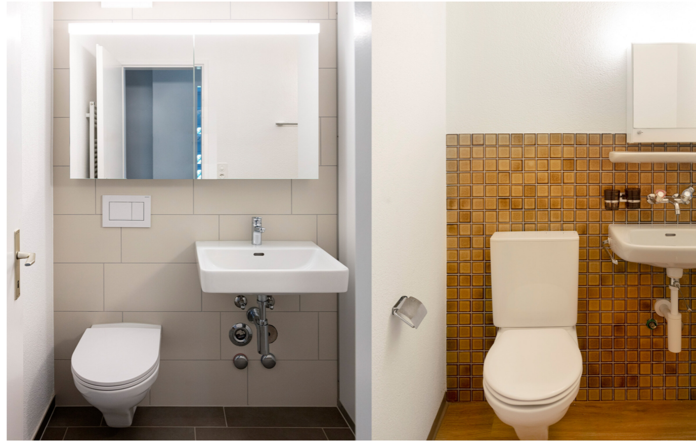
Nasszelle neu / Nasszelle vorher
