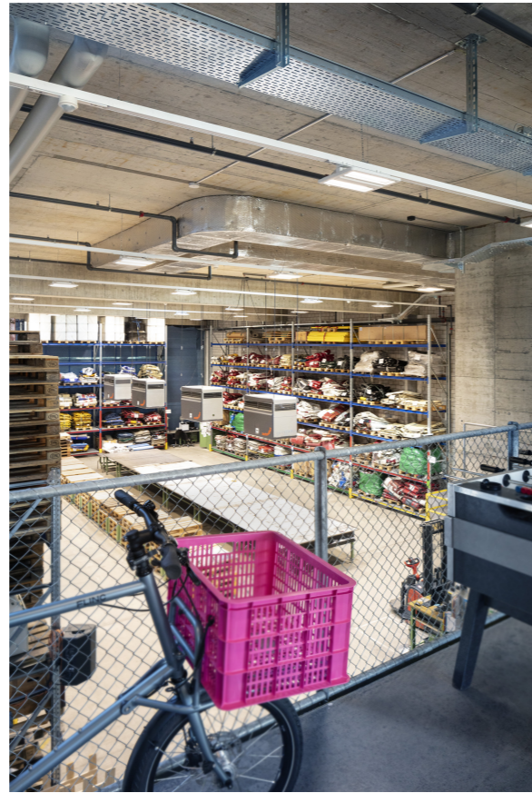
Neue Beleuchtung Halle
