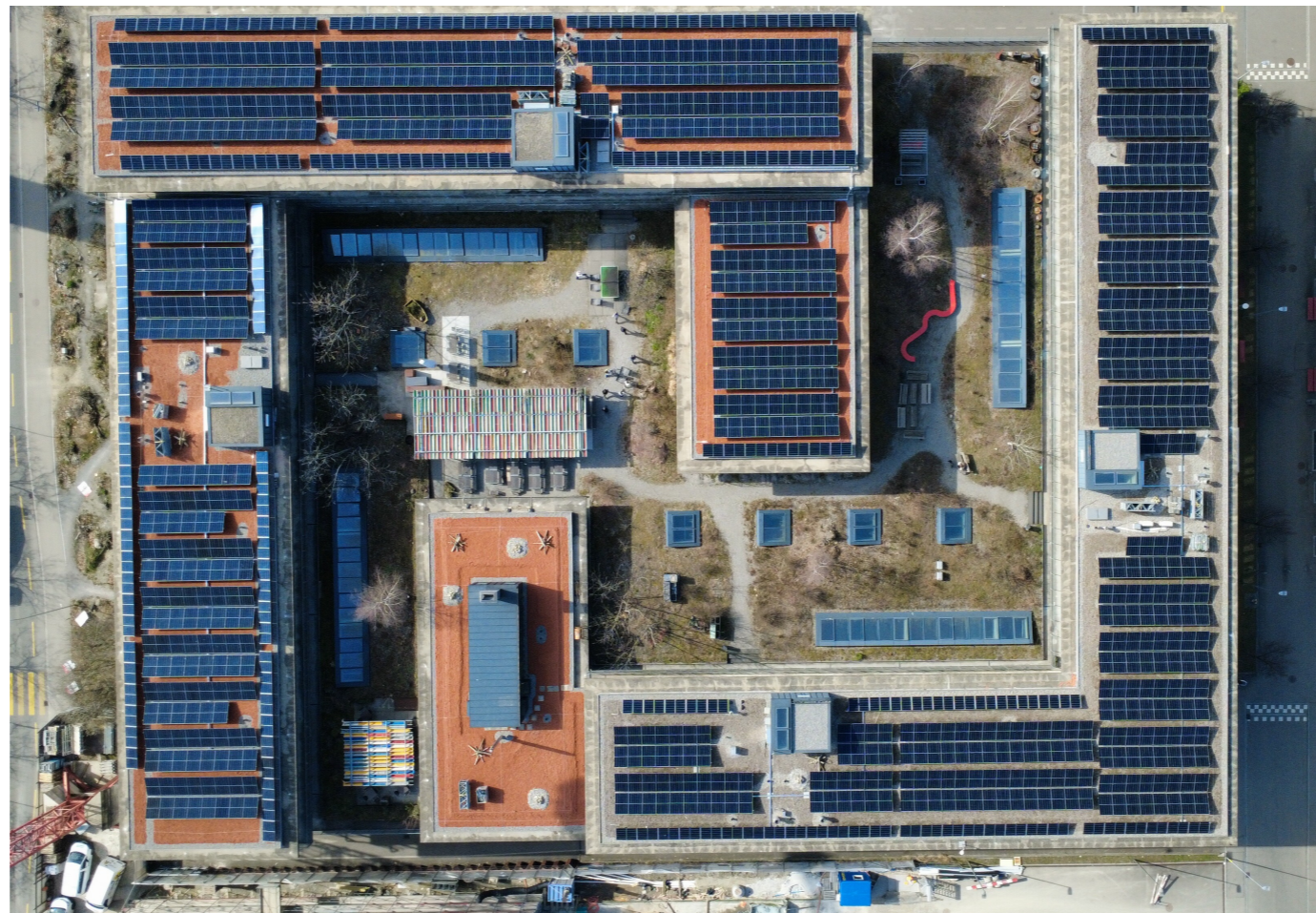
Vogelperspektive der PV Anlage
