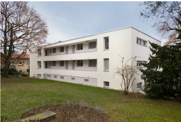
West- und Südfassade
