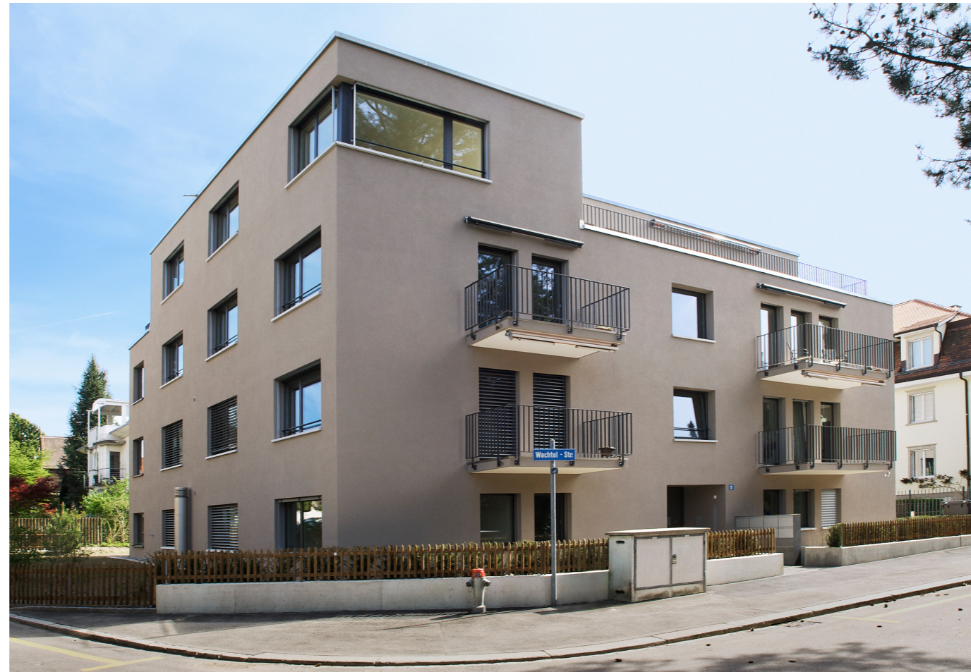
Nordost- und Nordwestfassade
