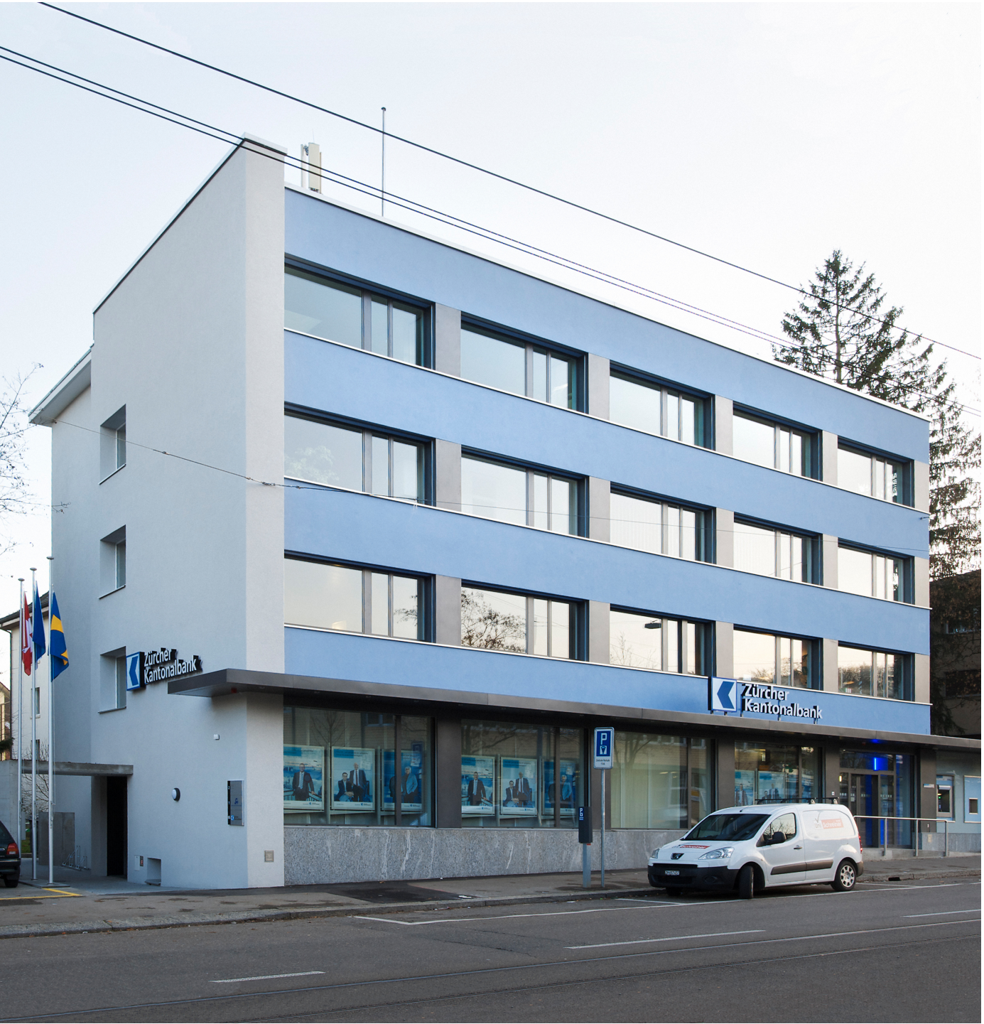
Aussenansicht von Albisriederstrasse
