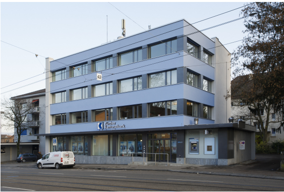
Aussenansicht von Albisriederstrasse
