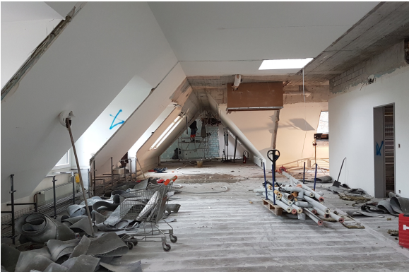
Dachgeschoss während Umbau
